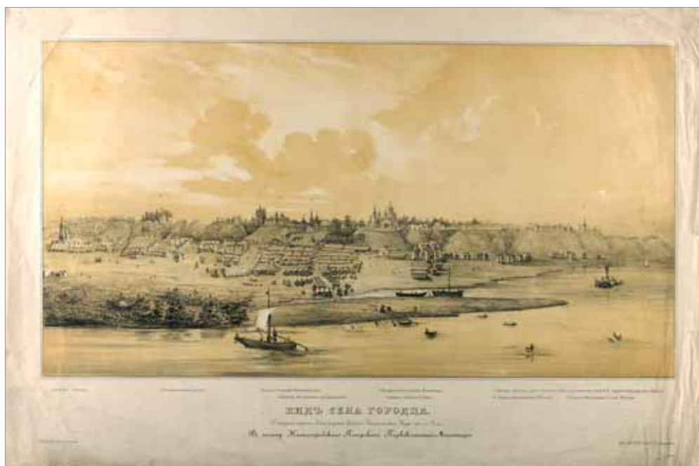
Лот 527. Вид села Городца. С западной стороны Нижегородской Губернии Балахнинского Уезда, при реке Волге. В пользу Нижегородского Печерского Первоклассного Монастыря. СПб.: Лит. Дарленга, [1880-е]. 74 x 49,5 см. Загибы, надрывы правого края.
